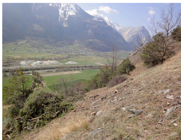
Fig. 11. Forstliche Massnahmen in der westlichen Zone (links in Fig.9), 19. April 2010.
